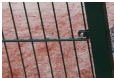
SPRÁVNÉ osazení ráků (v bezprostřední blízkosti sloupů)
