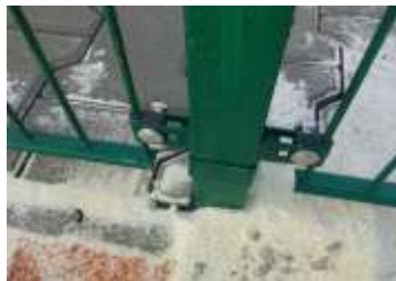
CHYBNÉ osazení ráků (velké mezery mezi ráky a sloupy resp. chybně otočená plast.vložka tzn.chybně rozteče v osazení sloupků)
