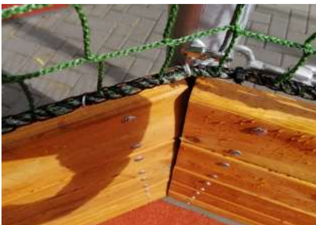
Chybně provedené napojení mantinelu v šikmém rohu
